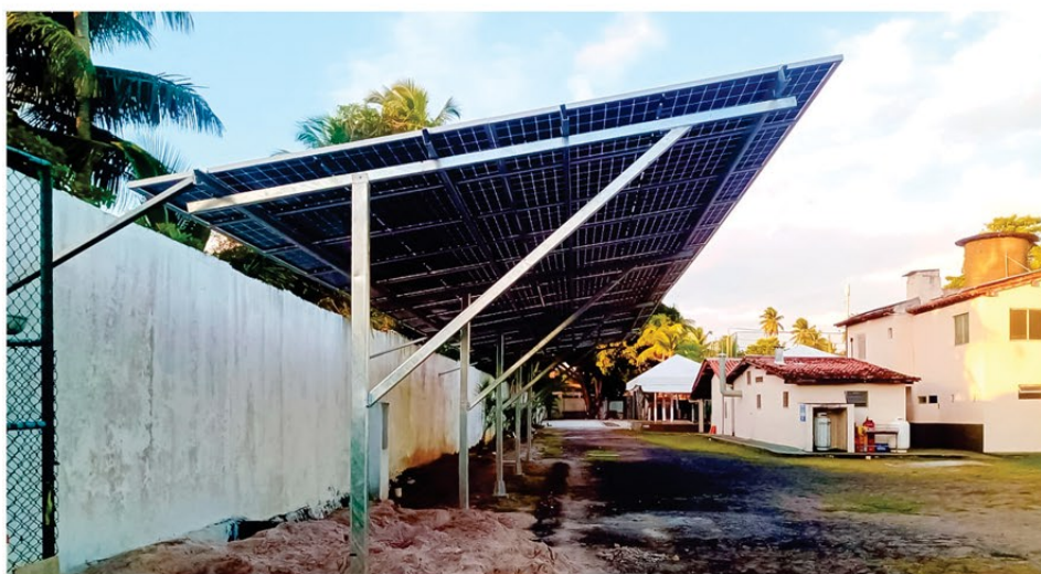
O projeto de implantação de energia solar deve ser concluído ainda em 2022
